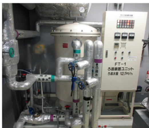
ろ過材交換・ろ過装置整備 ポンプ点検・交換
