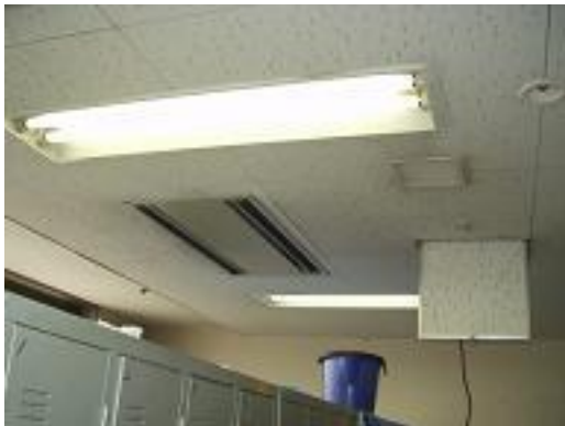
(写真-5) ファンコイル室
