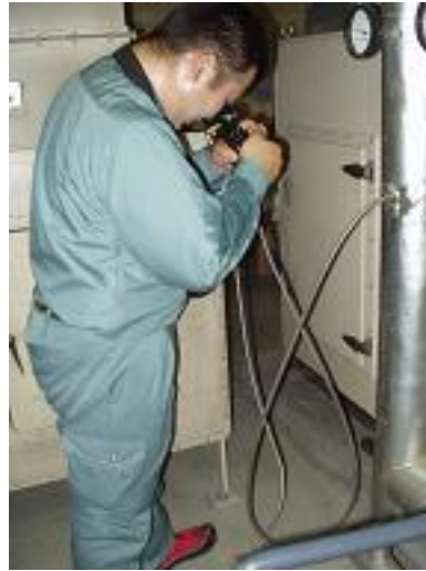
(写真-10) 空調機の内視鏡調査
