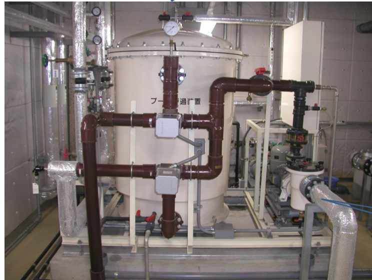
ろ過材交換・ろ過装置整備
